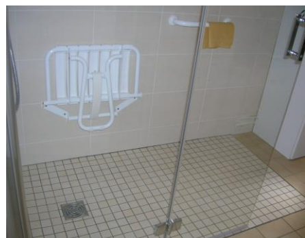
Douche italienne après travaux
