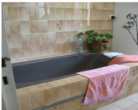
Salle de bain avant travaux
